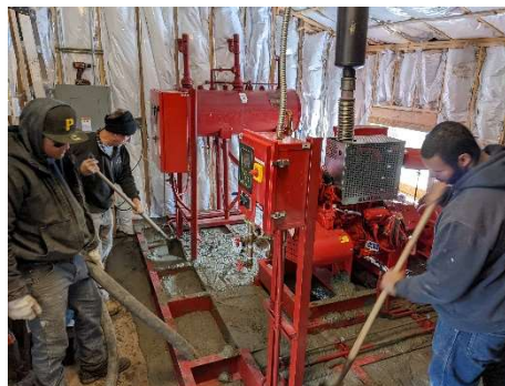
Concrete pour to stabilize the fire pump
